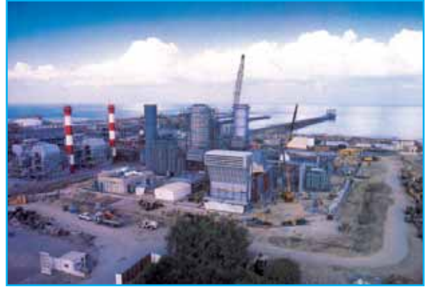
شكل (٢٣) محطة تحلية المياه بالغبرة
